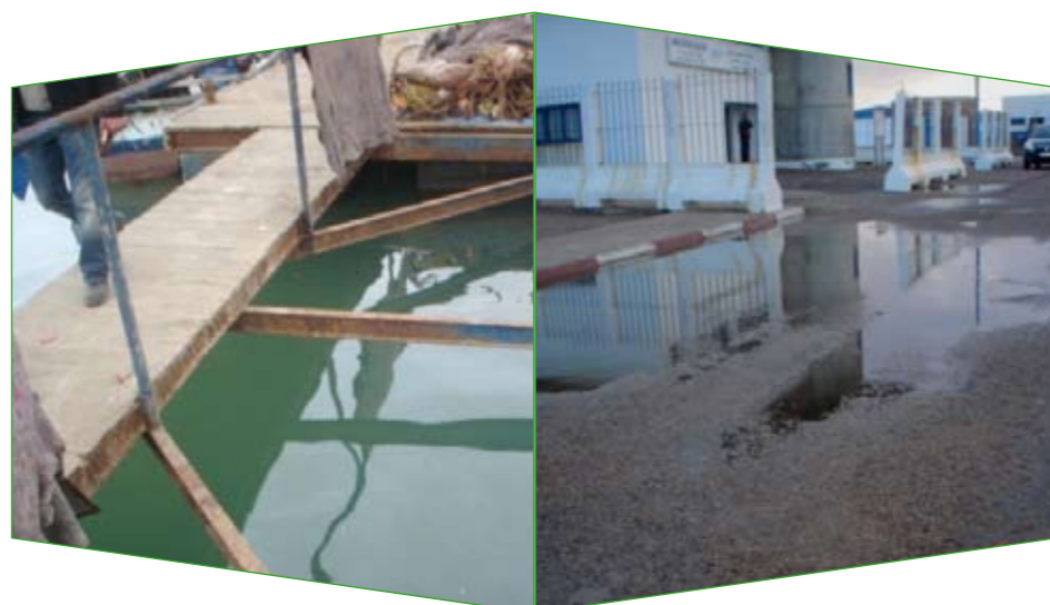
Exemples de bâtiment sans réseau d'assainissement et d'un ouvrage d'accostage particulièrement dangereux à réhabiliter.
