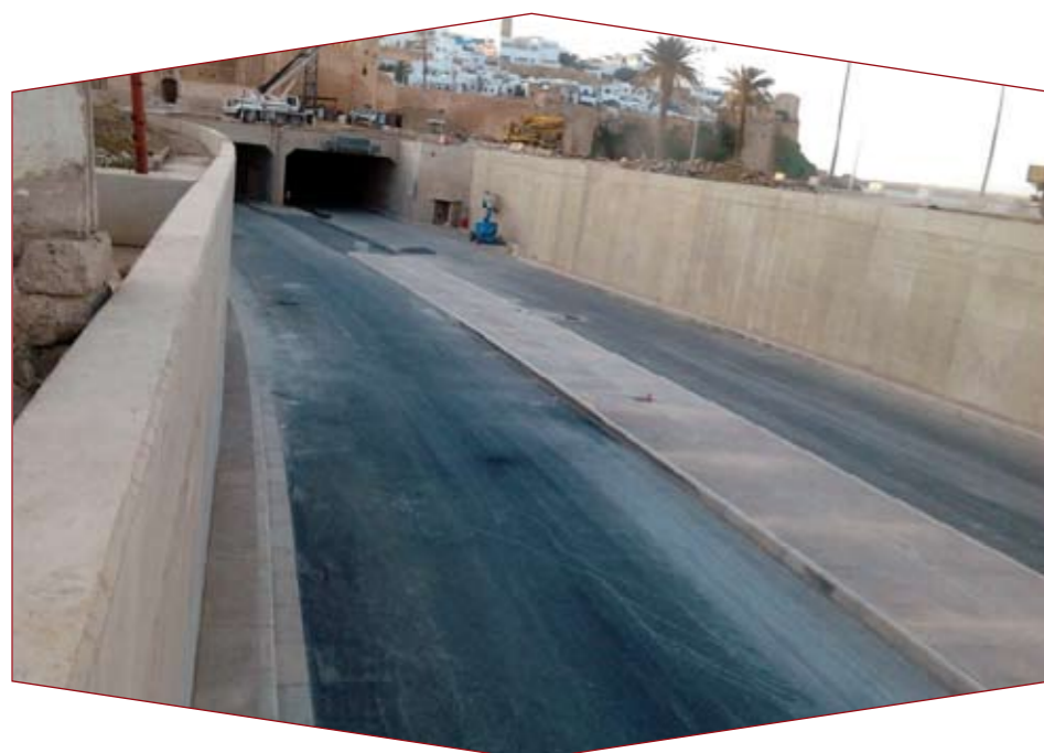
Une vue du Tunnel des Oudayas en cours des travaux.
