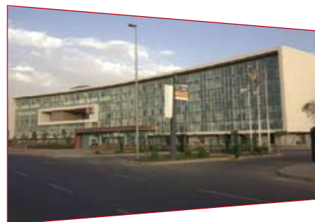
Une vue de l'entrée principale de Casaneashore park.
