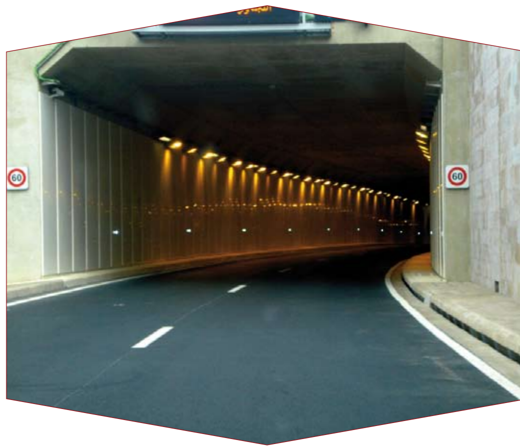
Une vue du Tunnel des Oudayas à l'achèvement des travaux.
