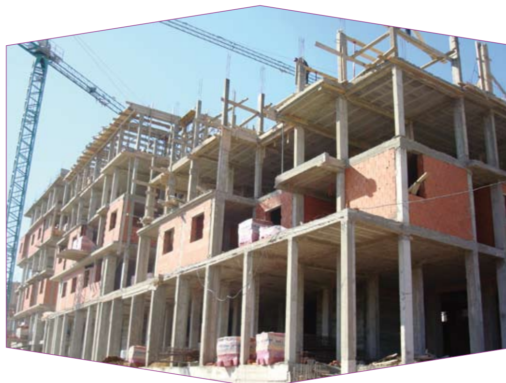
Chantier de construction de logements.
